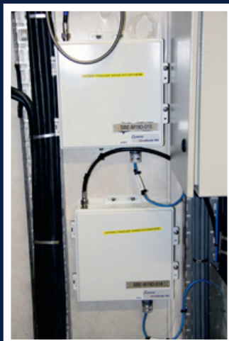
De trådløse Gatewayene, eller radioaksesspunktene, er installert i utstyrsrom, med antennene montert utendørs.
